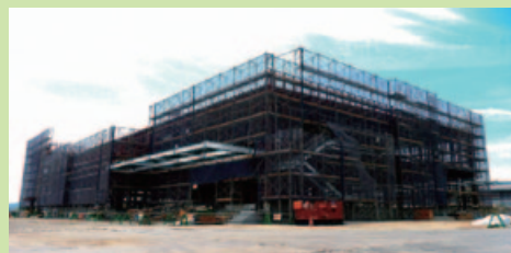
▲建設中の炊飯工場と青果プロセスセンター(神戸市北区)
