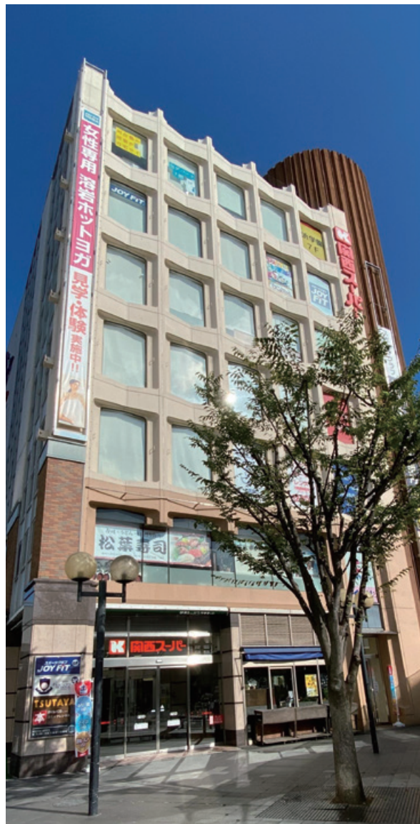
駅前店改装(2020年8月) (兵庫県伊丹市)
